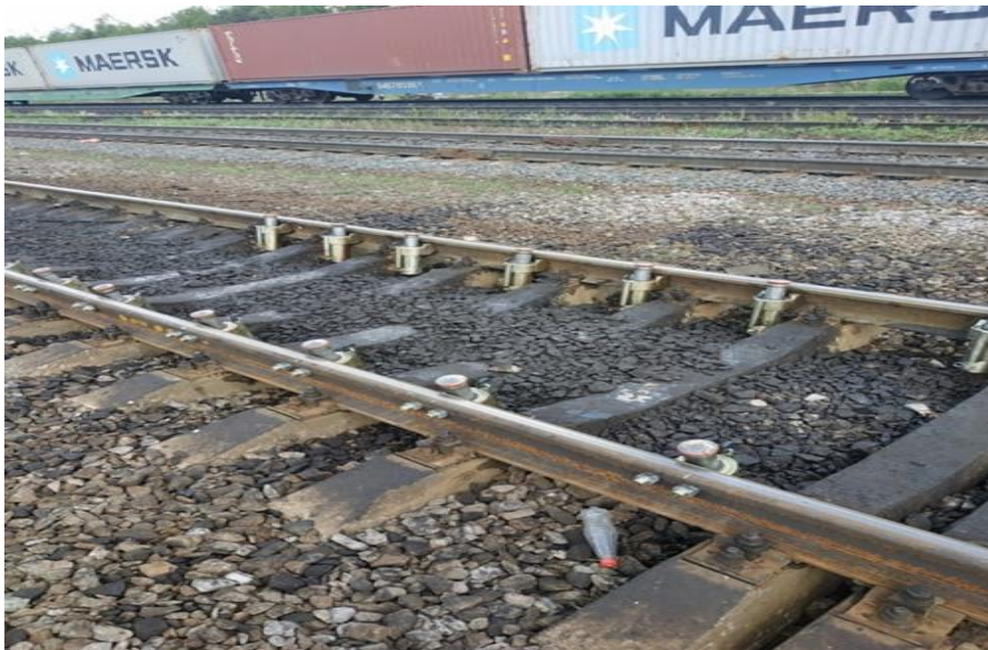
Рисунок 1 – Домкратовидные устройства закрепления
